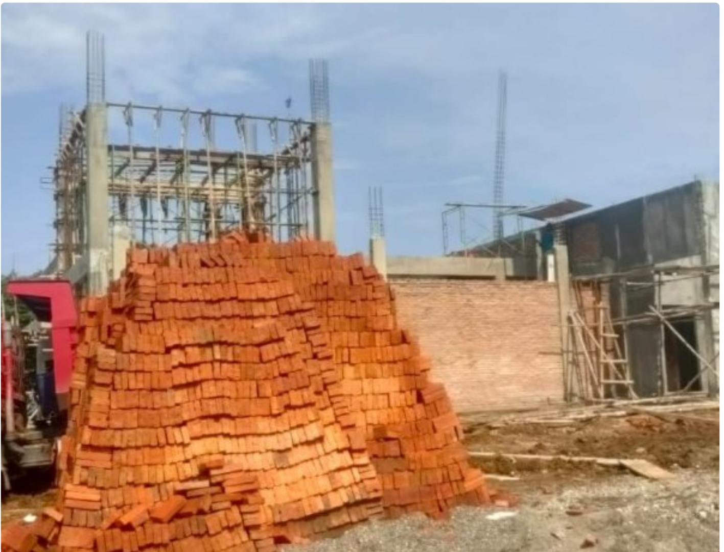
Tampak Pembangunan Kantor Inspektorat Morowali sedang berlangsung
